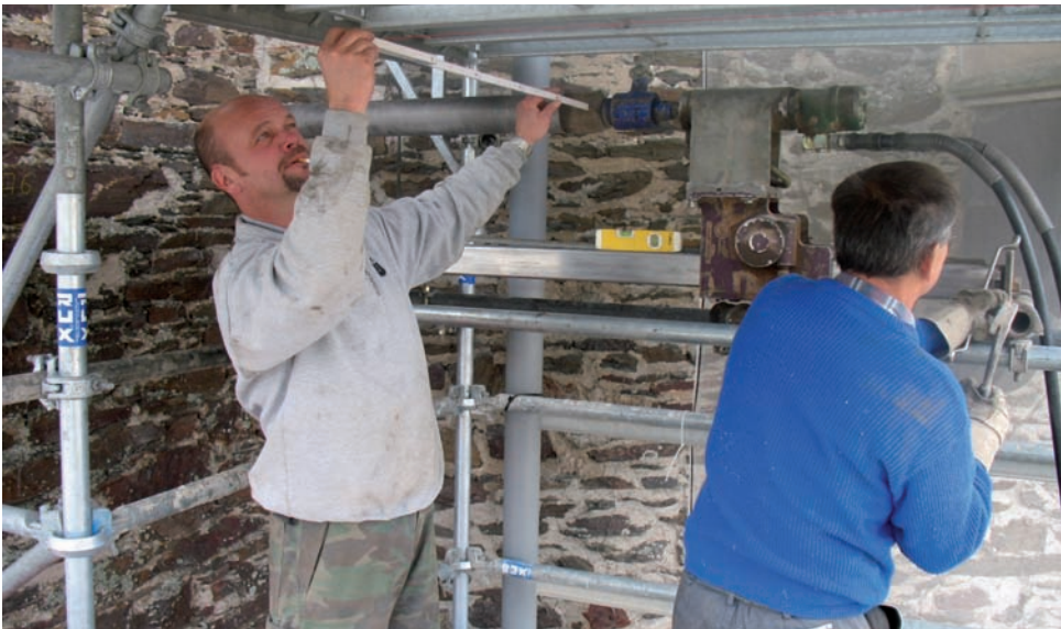
Abb. 6: Einrichten der Bohrlafette am Bohrpunkt.
