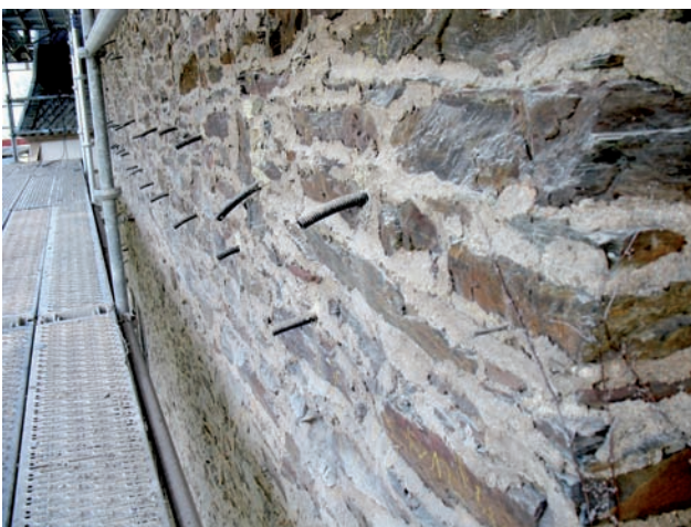
Abb. 11: Verpressstützen entlang der Ankerstrecke.
