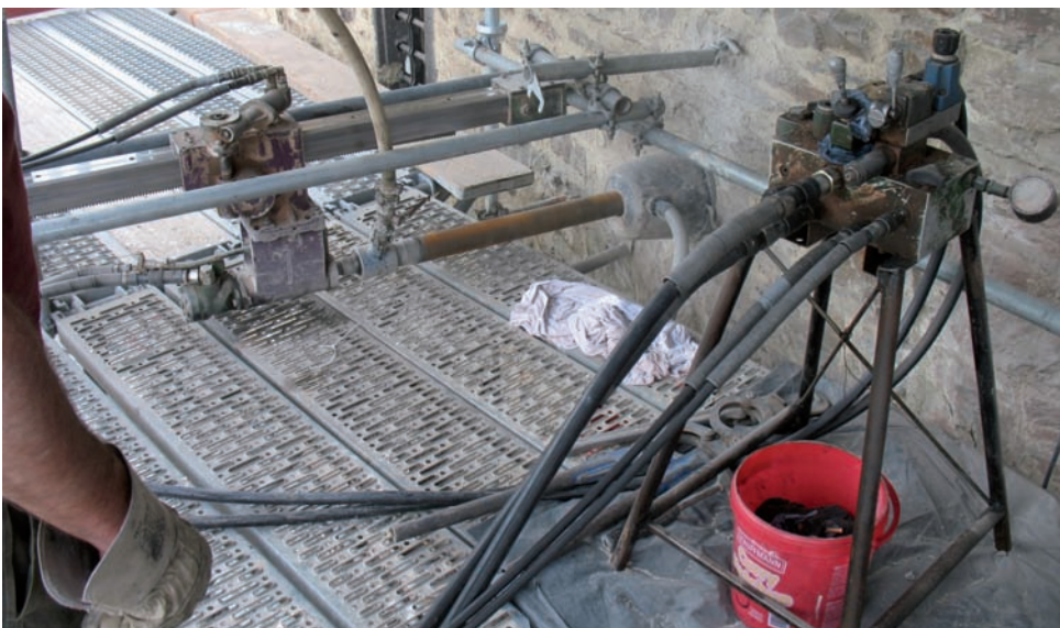
Abb. 7: Kernbohrgerät mit Steuertisch.
