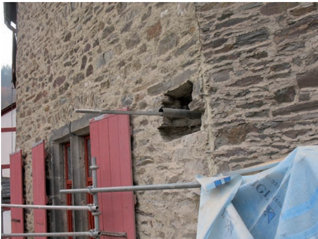
Abb. 10: Eingebauter Zuganker Staifix gerippt mit Endgewinde.
