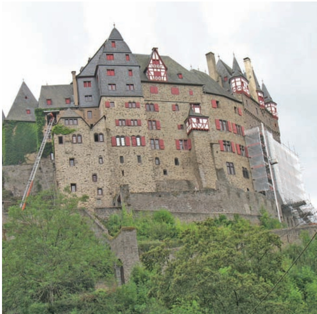
Abb. 1: Groß Rodendorfer Haus mit Arbeitsgerüst.
