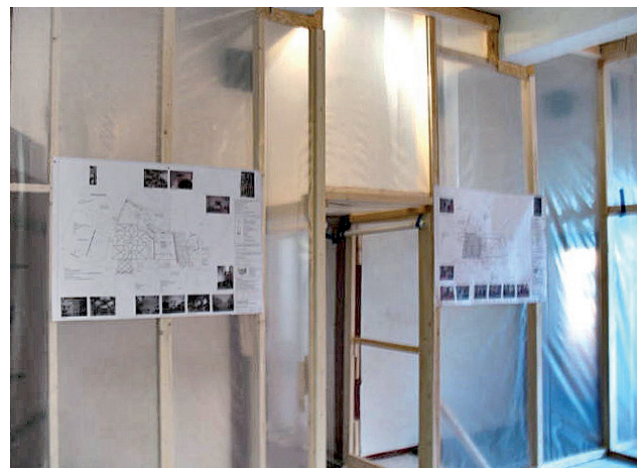
Abb. 5: Staubschutzwände.
