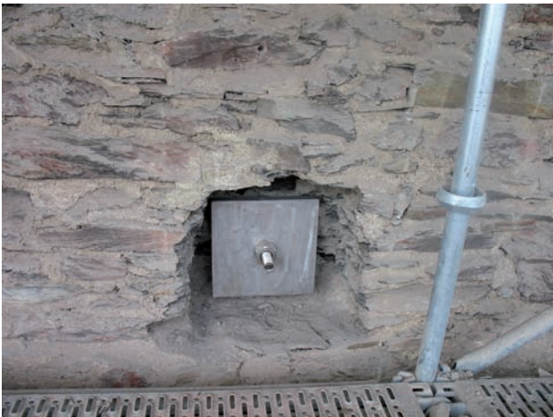
Abb. 9: Ankerkopf mit Ausbruch, Ankerstahl, Ankerplatte und Mutter.
