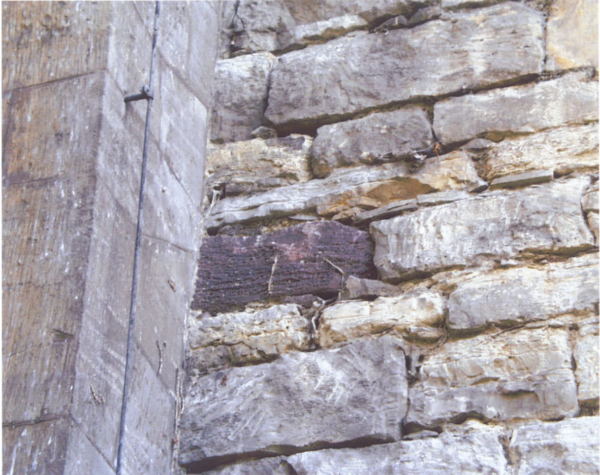
Bild 4: Mauerstein aus rötlichem Konglomeratgestein im Sichtmauerwerk der Stützwand
