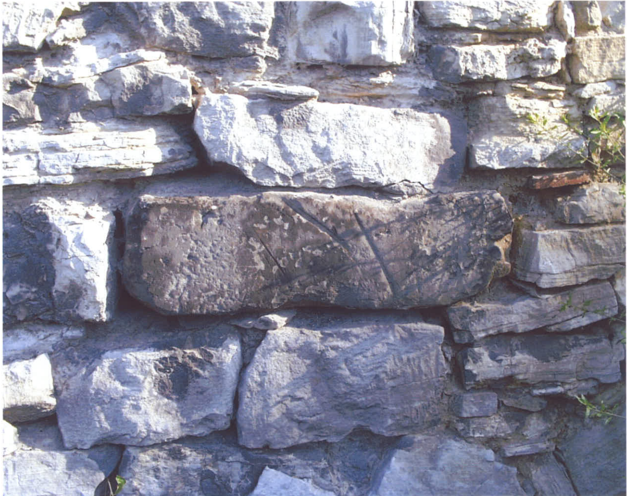
Bild 6: Mauerstein aus Sandstein im Sichtmauerwerk der Stützwand
