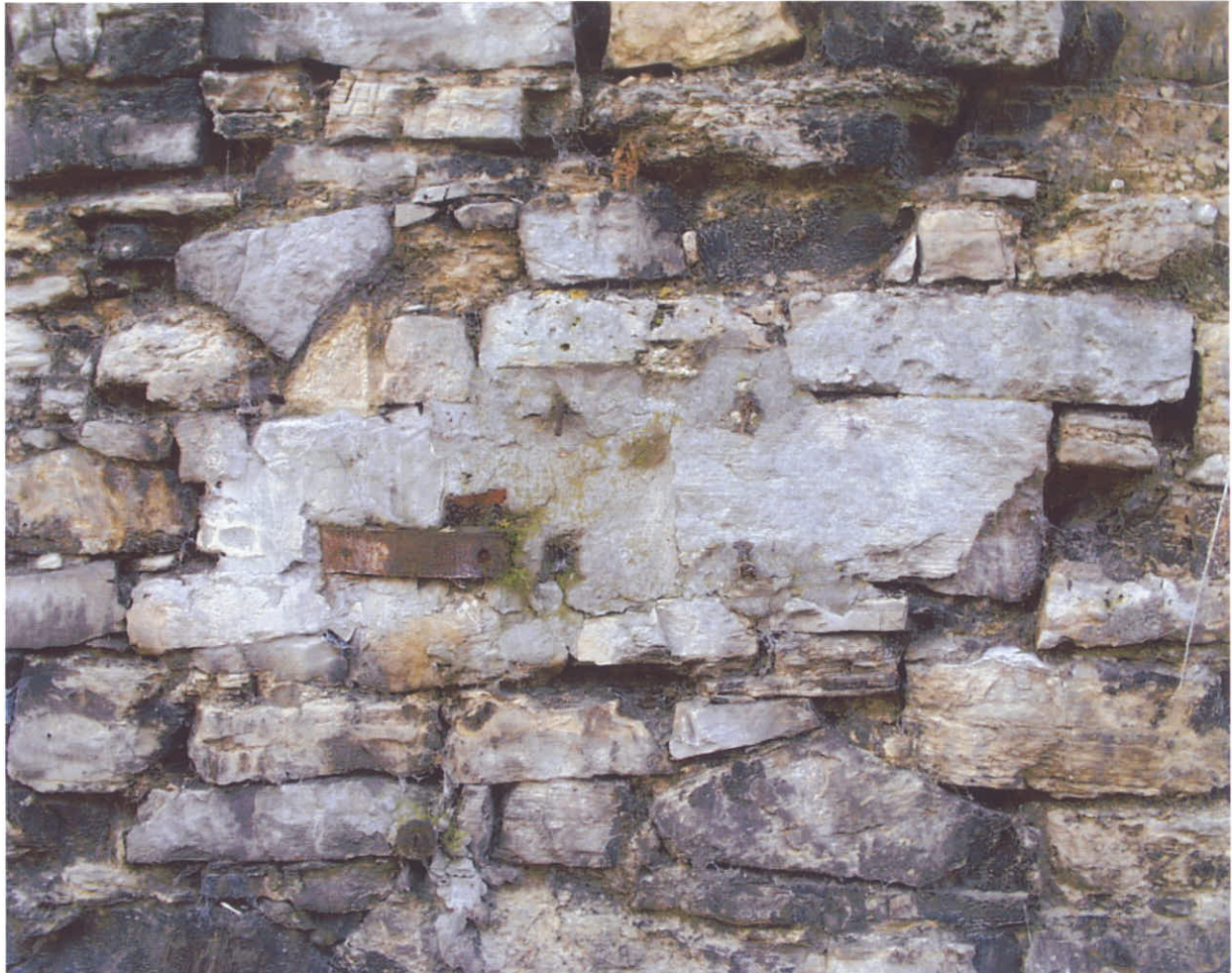
Bild 10: Mit Zementmörtel ausgebesserter Bereich zwischen Achse 23 und 24
