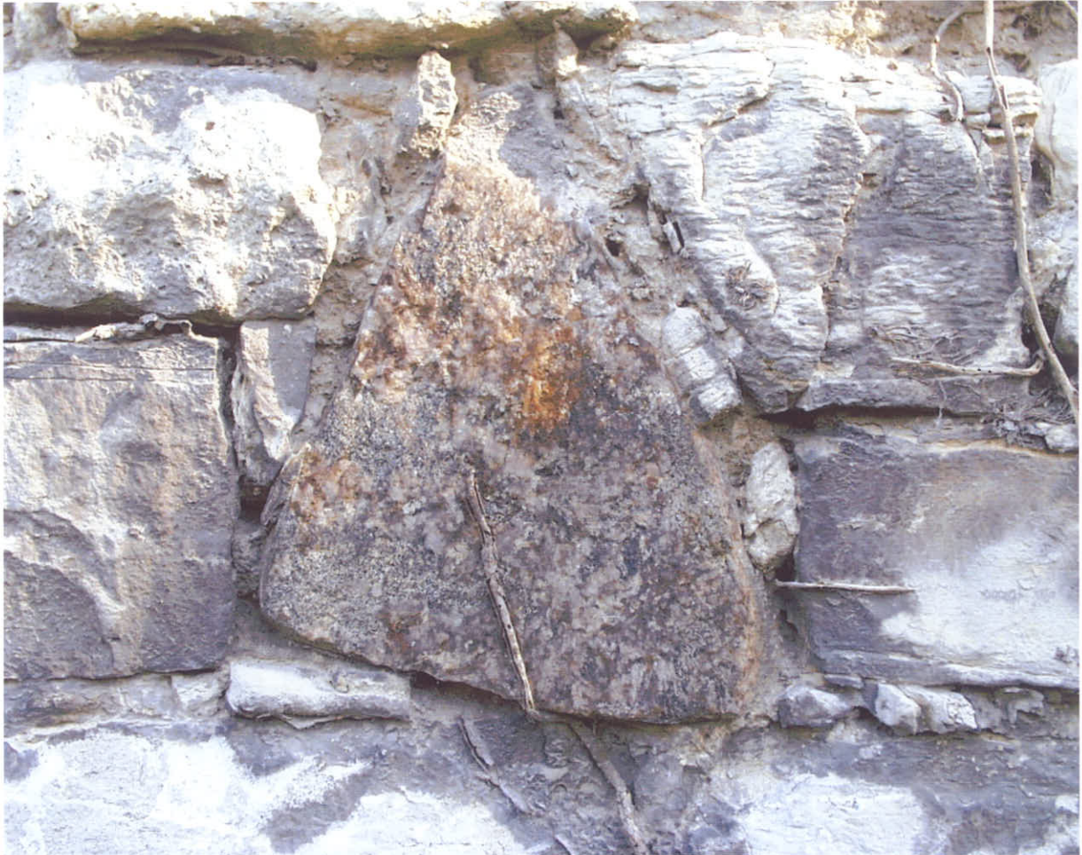
Bild 5: Mauerstein aus Hartgestein (Findling)im Sichtmauerwerk der Stützwand
