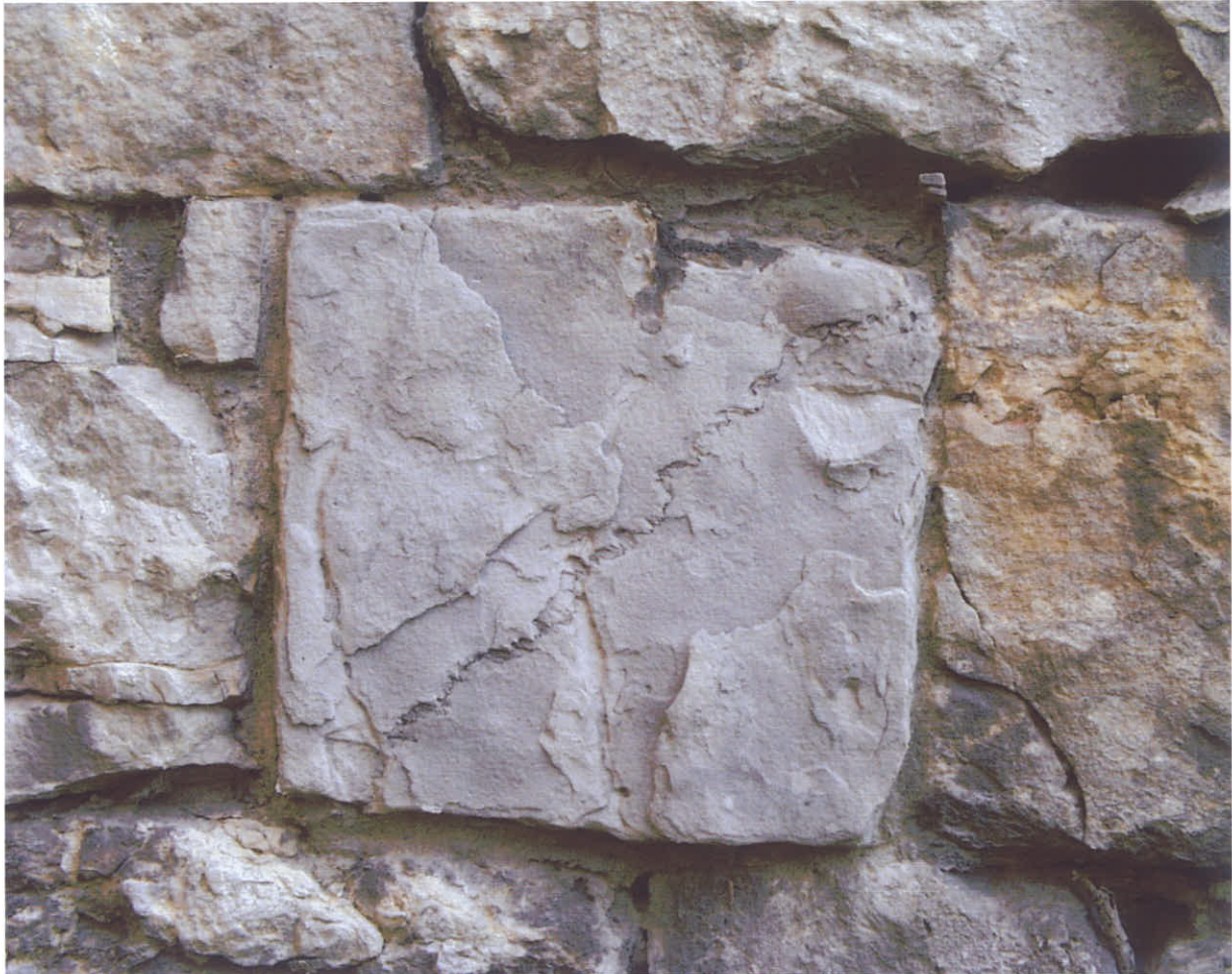
Bild 16: Schalenbildung an einem Stein des Sichtmauerwerks, der gegen das Lager (Schichtung senkrecht) verbaut wurde.
